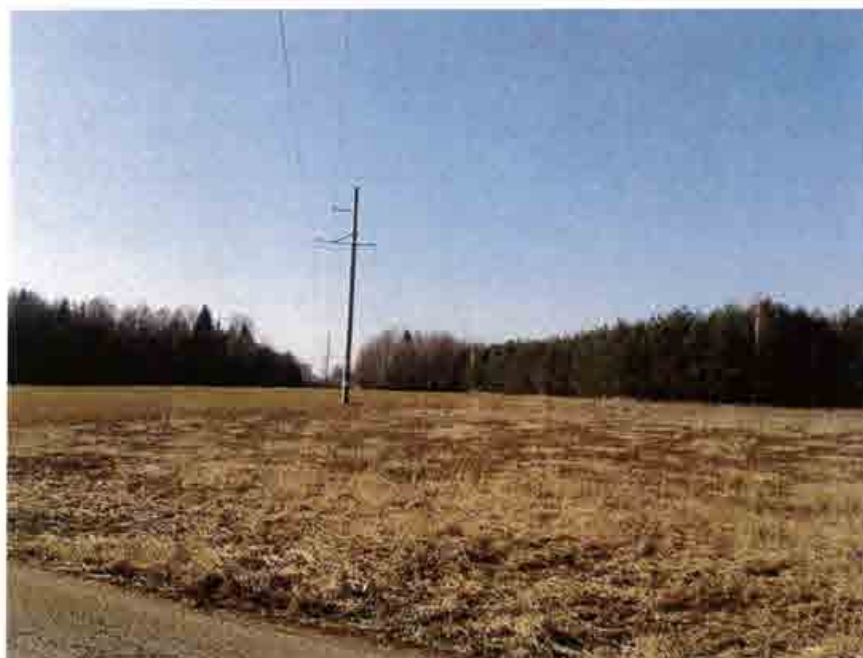
3.4.1. pav. Fotofiksacija. 110 kV elektros oro linija.
